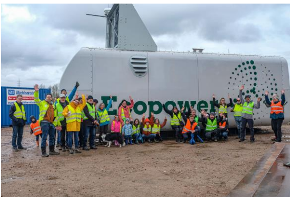
Ecopower coöperanten bezoeken de bouwplaats van een windturbine (Schelle, BE, 2023)
