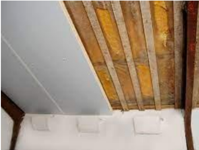
Figur 1: Loftsisolering af gammel svinestald ved hjælp af polyisocyanurat (PIR) (kilde: Recticel Insulation)
